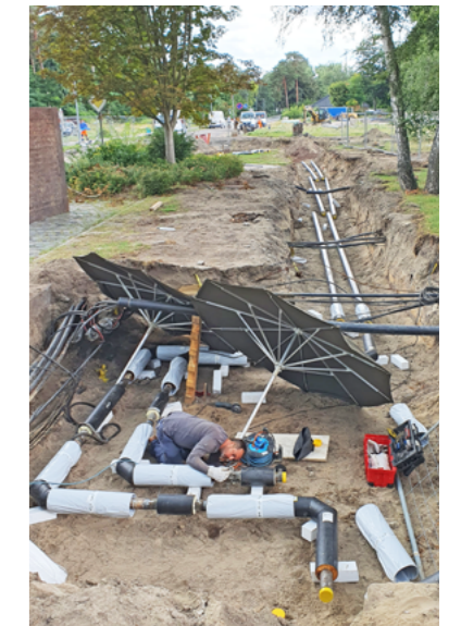
Schweißarbeiten am Dehnungsbogen an der Hauptleitung in der Bergstraße.
