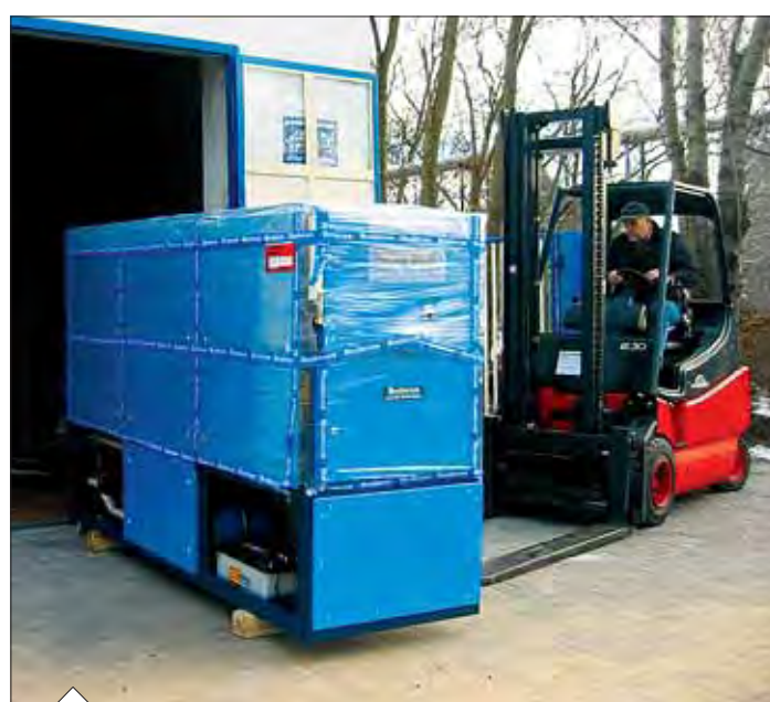
Schnell ist das neue BHKW eingebaut.
