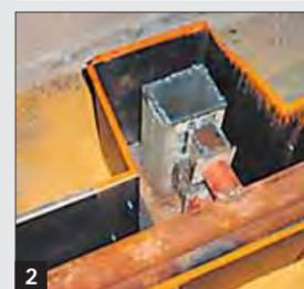
1: Solch ein Kanal ist zu verfüllen, weil das darüber stehende Gebäude abgerissen wird. Zuerst werden die Isolierungen entfernt
