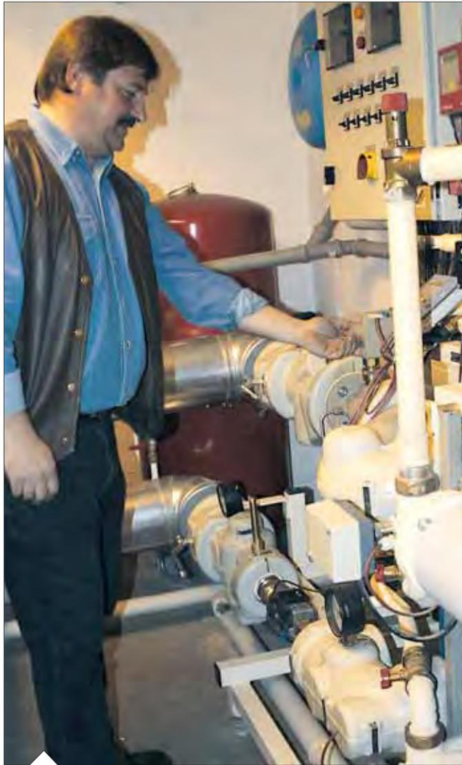
**Die Stadtwerke liefern Fernwärme an 90 Nahwärmestationen. Frank Hahn begutachtet die Steuerung. Die Wärme aus den Fernleitungen wird an dieser Station auf die Abnehmer verteilt.**
