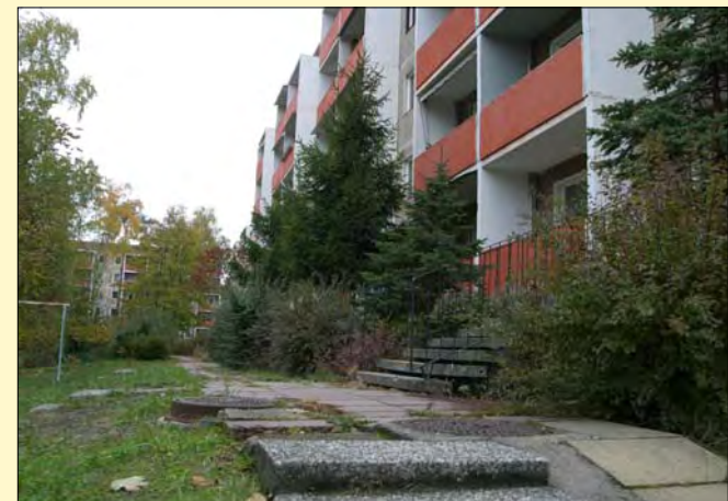
Vor allem in der Bergstraße/Bunsestraße ist Rückbau geplant.
