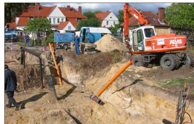
Verlegung von Gasrohren im „Säuregraben“.
