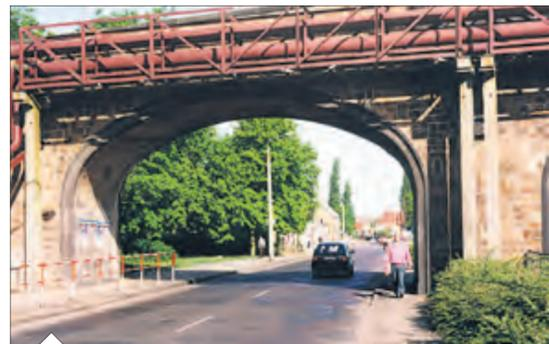
Anfang der Neunziger Normalität: „oberirdische Wärmeverschwendung“. Doch ziemlich schnell fanden sich die Sockeltrassen samt Fernwärmehohr unter der Erde wieder.
