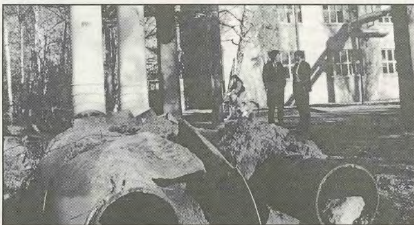
...leisteten die Stadtwerke mit dem Abbau der alten Fernwärmetrasse
