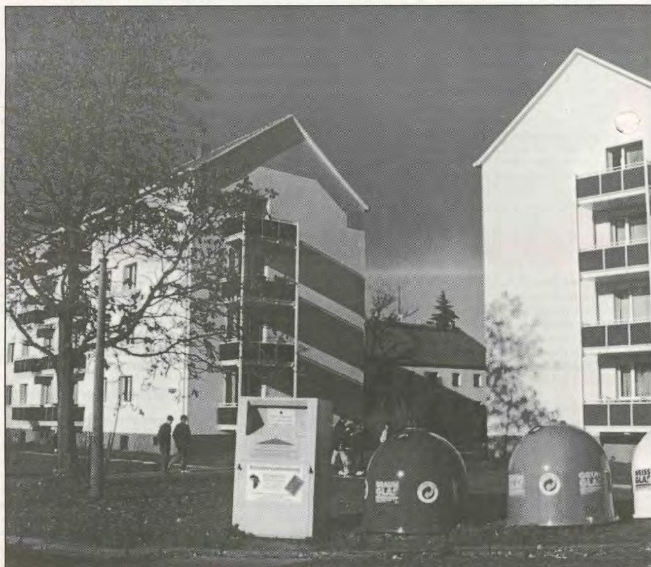
Im Neuen Zentrum entstanden in den fünfziger Jahren die ersten fernwärmebeheizten Wohnungen in Premnitz, jetzt wurden die Anschlußstationen ausgerüstet.
