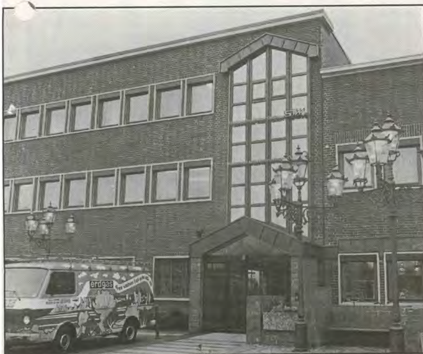
Das Stadtwerksgebäude in Willich
