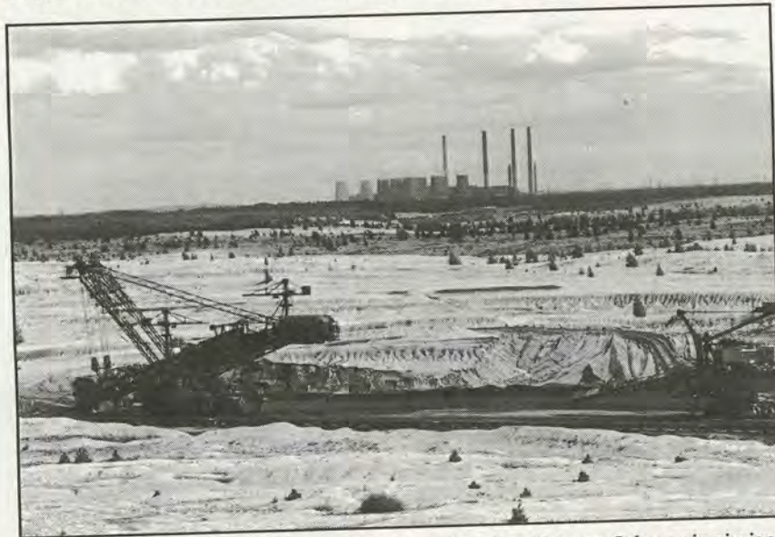
Wo sich einst der Tagebau Lohsa II befand, soll in den nächsten Jahren ein riesiger Wasserspeicher mit 8.000 ha Fläche entstehen. 16,7 Mio m 3 Erdmassen sind zu bewegen, bis im Jahre 2005 mit der Flutung begonnen werden kann. LBV-Werkfoto
