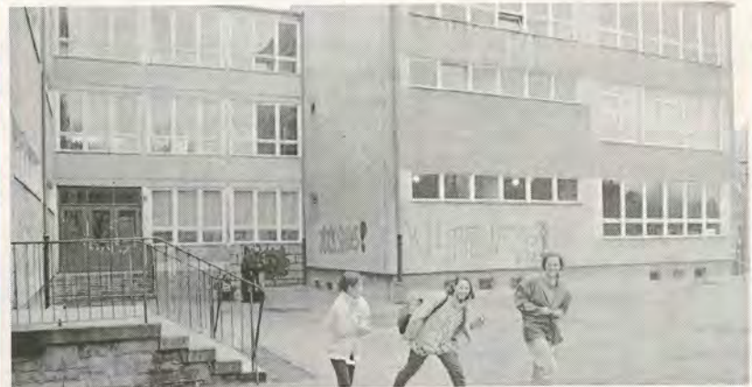
Die Schule in der Bergstraße erhält eine eigene Gas-Nahwärmestation.
