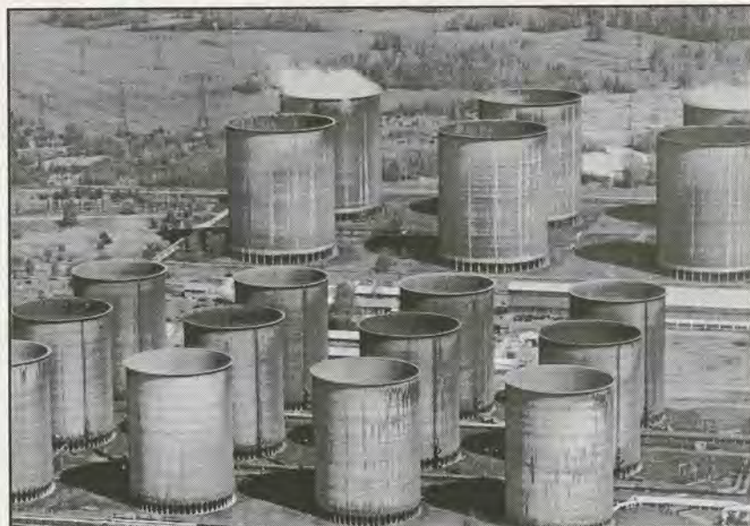
AUSGEDIENT haben mit den Kraftwerksanlagen in Vetschau auch die Kühltürme
