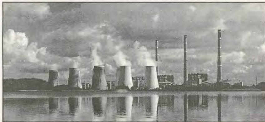
Moderne Rauchgasentschwefelungsanlagen werden im Kraftwerk Jänschwalde installiert. Ab 1996 wird sich pro Jahr der Ausstoß von Schwefeldioxid um 271.600 t, von Stickoxid um 17.800 t und von Staub um 6.300 t reduzieren Foto: Veag
