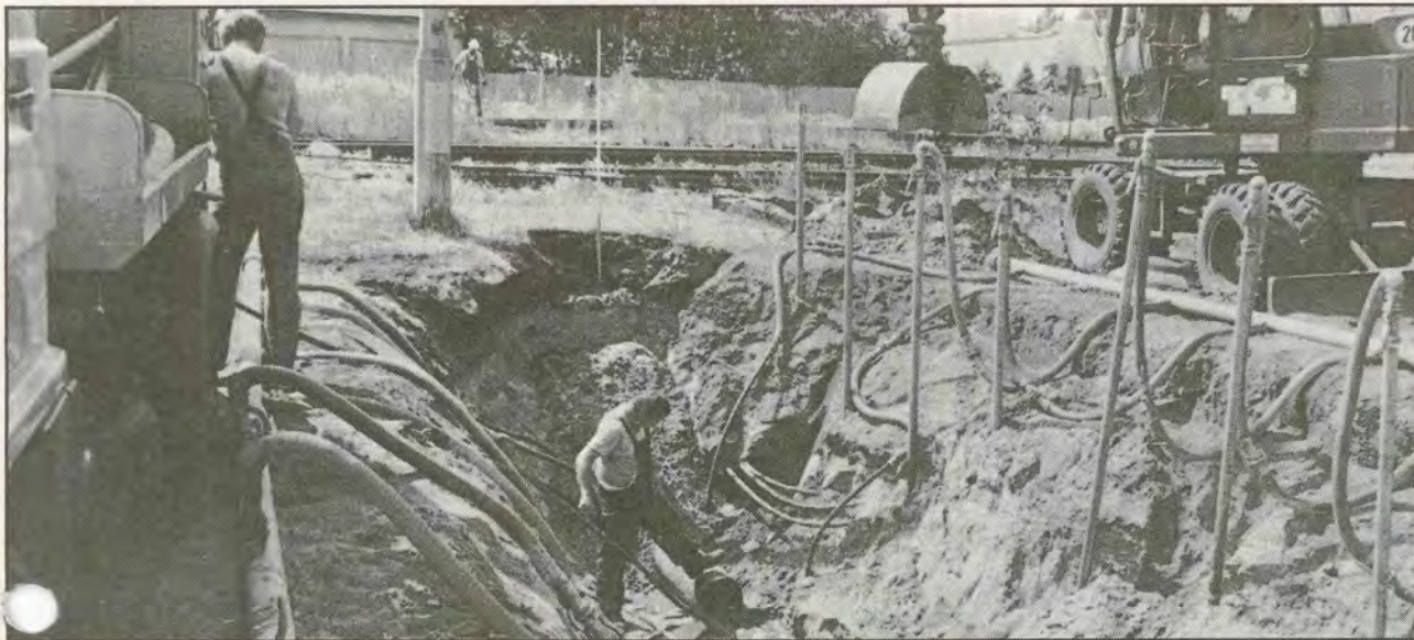
Ein Schnappschuß von der „Durchörterung“ der Bahntrasse
