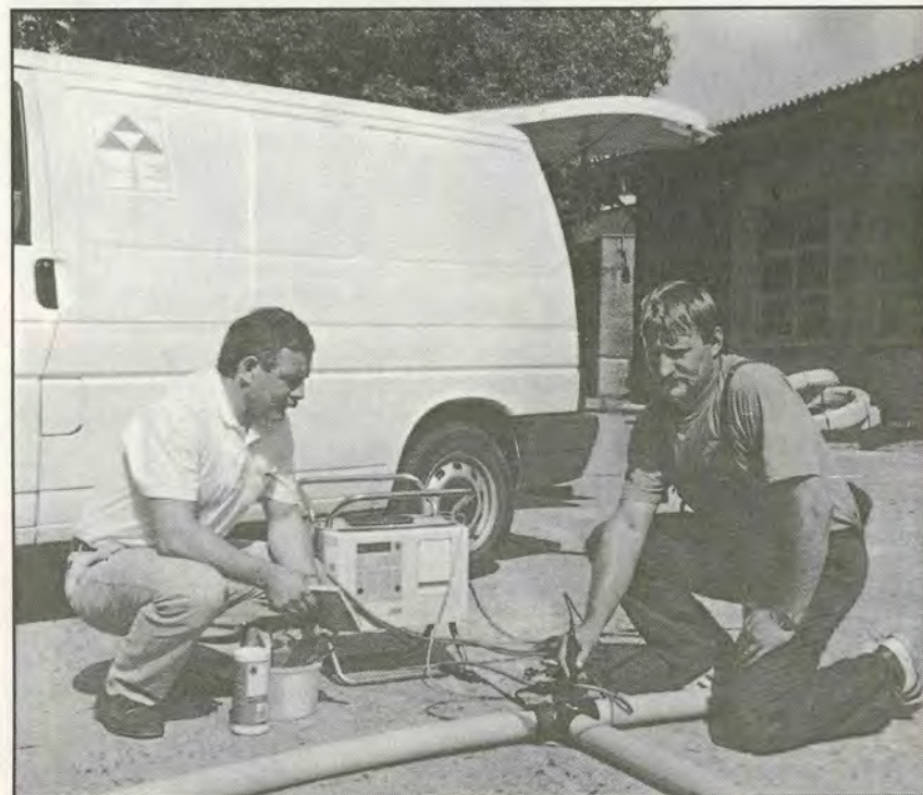
Bauleiter Arno Geiert (l.) und Monteur Norbert Els beim Fittingschweißen
