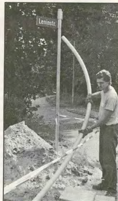
Norbert Stengel von Bau Klein Kreuz bei Verlegearbeiten in der Leninstraße
