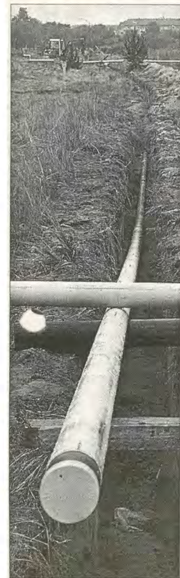
In Milow (links) wurden in diesem Jahr knapp 200 Haushalte an das Gasnetz der Stadt Premnitz angeschlossen. Die Verlegearbeiten der Leitungen (oben) wurden von Firmen aus der Region ausgeführt. Im nächsten Jahr sind weitere Anschlüsse, u. a. für ein Gewerbegebiet, vorgesehen.
