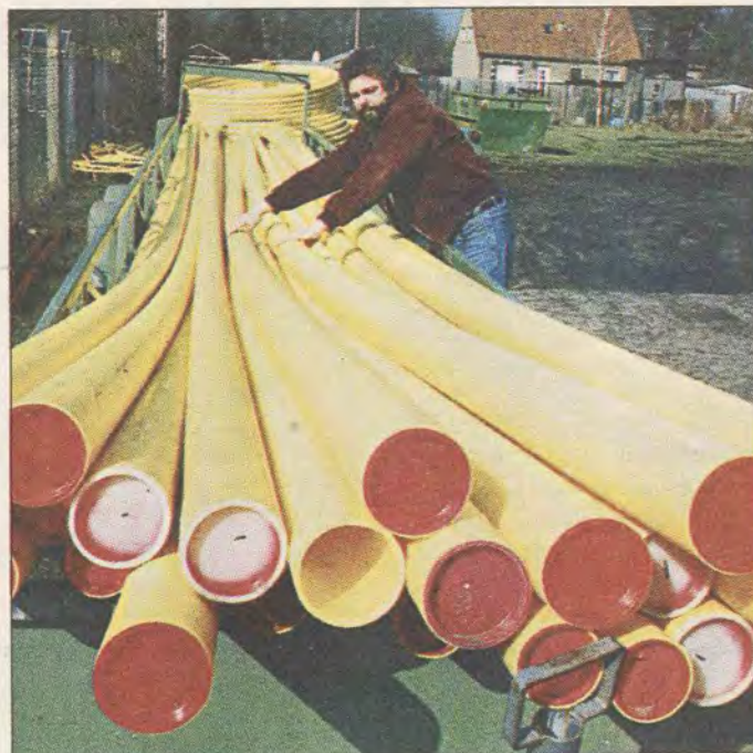
Viele Rohre sind notwendig, um Hausanschlüsse zu verlegen
