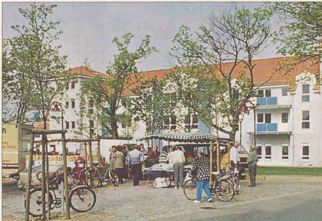
Das neue Wohn- und Geschäftshaus am künftigen Premnitzer Zentrum schließt das Marktplatz-Karree ab
