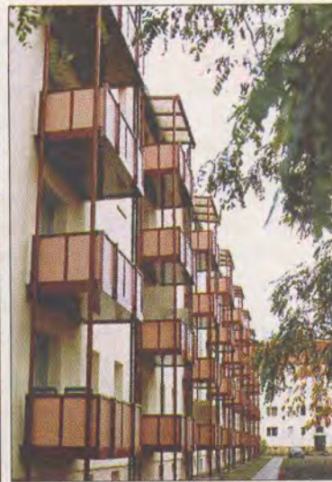
Sanierte Häuser in der Waldstraße
