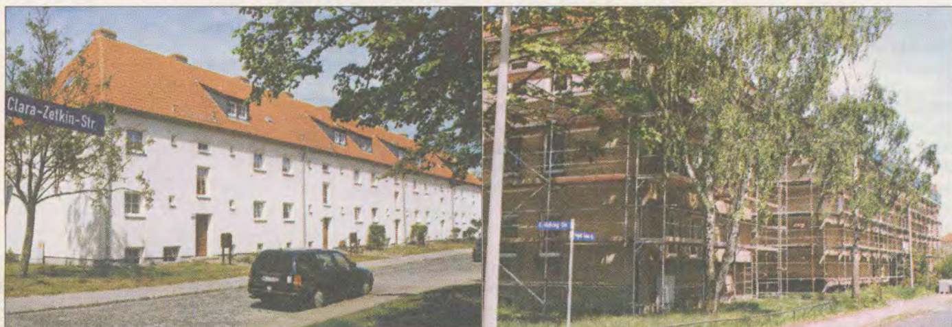
Das alte Zentrum von Premnitz zwischen Berg- und Heinrich-Heine-Straße wird nun komplett von den Stadtwerken mit Gas versorgt
