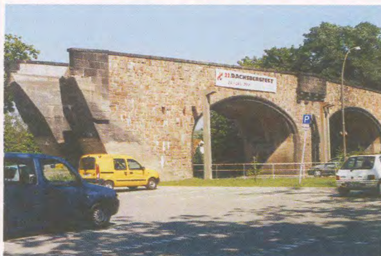
Die alte Brücke, über die früher die Hafentram fuhr, wird künftig saniert
