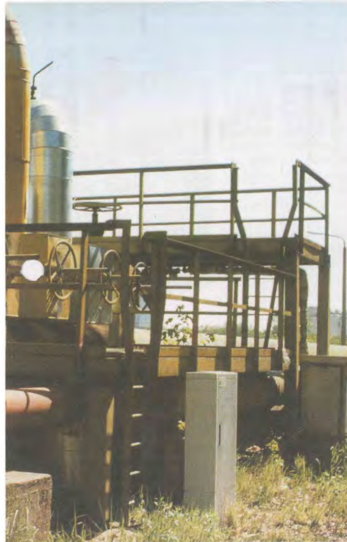
Aktion: die mächtigen Rohre der Fernwärme. Die Stadtwerke Premnitz Kr... verkes ab
