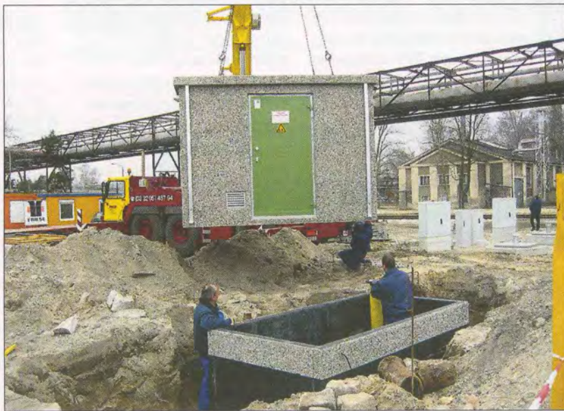
Mittels Kran wird das vormontierte Reglerhäuschen eingehoben.
