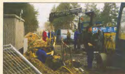
Ausbau des Erdgas-Hochdrucknetzes für die Industriefläche.
