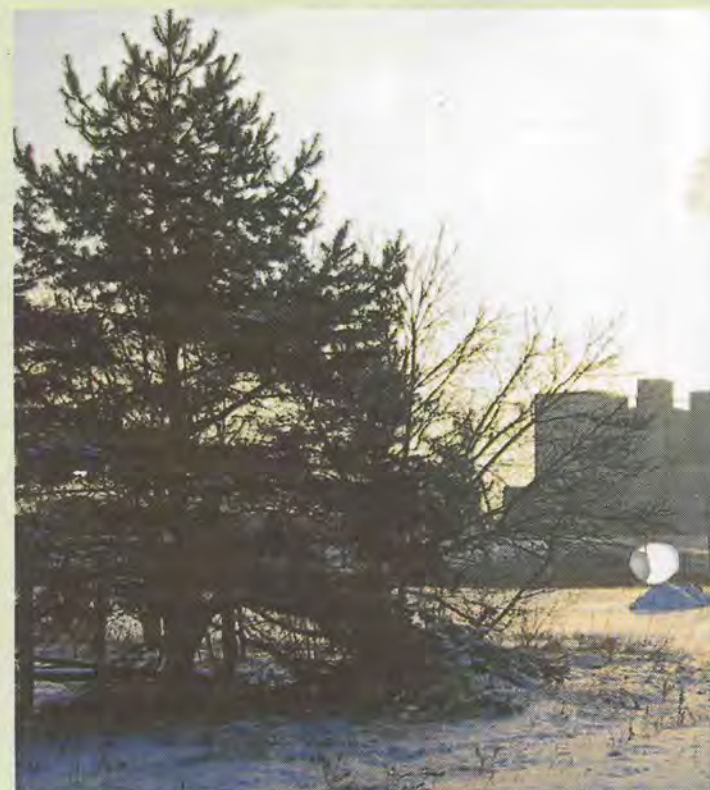
Im Zentrum des Energieverbundes steht das Kraftwerk.
