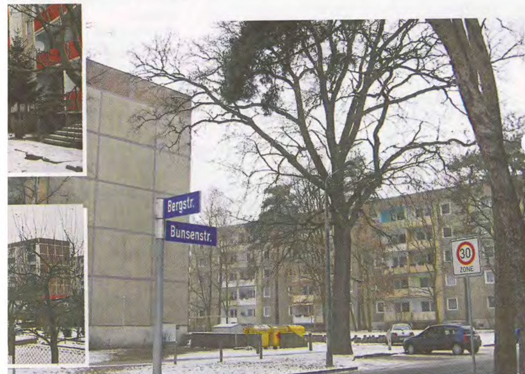
Bergstraße/Bunsenstraße wurden bislang nicht saniert. Rückbau steht zur Debatte.
