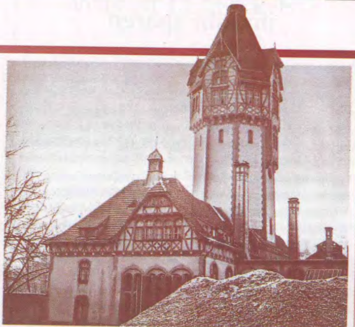
Hier eine Aufnahme des Fernheizwerkes aus den 70er Jahren.
