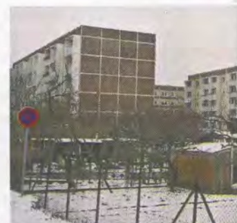
Die WBS-70-Bauten im Bereich de
