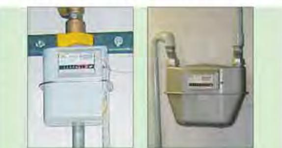
Neu installierter Gaszähler (Foto links) und alter Gaszähler (Foto rechts).
